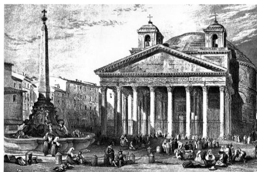
Εικόνα 12. Ρώμη, Pantheon, Santa Maria ad Martyres, 17 ος αιών. Μετατροπή σε εκκλησία, προσθήκη δύο καμπαναριών, αρχιτέκτων του Μπαρόκ Gian-Lorenzo Bernini (Napoli 1598-Roma 1680), τα καμπαναριά κατεδαφίστηκαν το 1839
