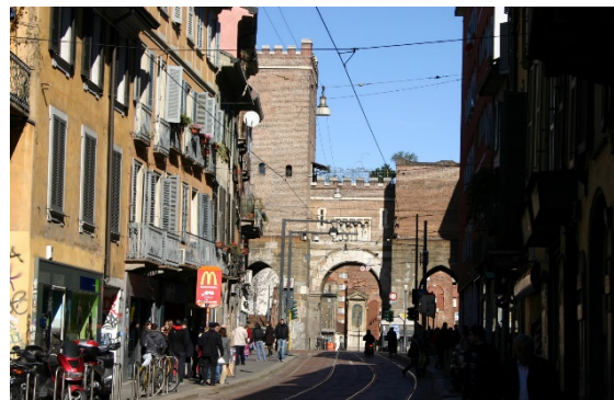
Εικόνα 14. Porta Ticinese στο Μιλάνο, 2007 ( αποκατάσταση του Camillo Boito, 1865 ) Φωτογραφία © Giovanni dall'Orto
