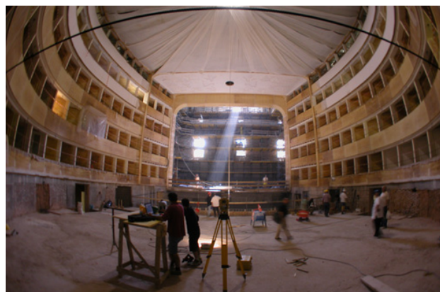
Εικόνα 20. Ιούνιος 2003, ανακατασκευή με ξύλο των θεωρείων © E.FABBRI Κατασκευαστική Εταιρεία Α.Τ.Ι. Holzmann, μελέτη αρχιτέκτων Aldo Rossi.
